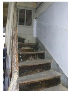
Immeuble avec façades pierre et structure bois y compris ensemble cage d'escalier (parois et marches) structure de l'escalier en bois en très mauvaise état sécurité incendie - isolation au feu des éléments communs non assurée
