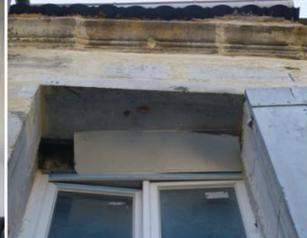
Etanchéité à l'eau et à l'air non assurée, dégâts des eaux visibles sous terrasse et menuiseries inadaptées
