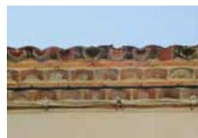
/ Une **génoise** : un empilement de tuiles sur plusieurs hauteurs disposées en quinconces, remplies de mortier de chaux, venant constituer un léger débord au-dessus de la façade pour la protéger.
