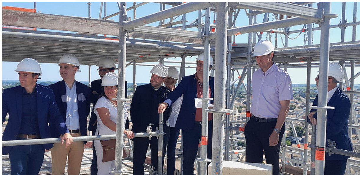
Visite du chantier de remontage de la flèche de l'église Saint-Jean-Baptiste
