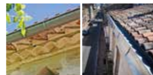
gouttière pendante chéneau encastré
