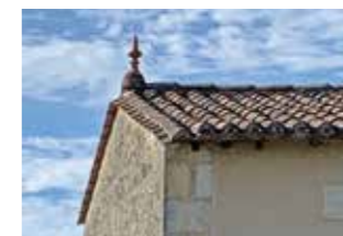
tuiles canal avec épis de faitage
