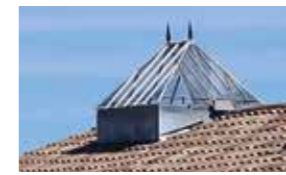
verrière sur une cage d'escalier
